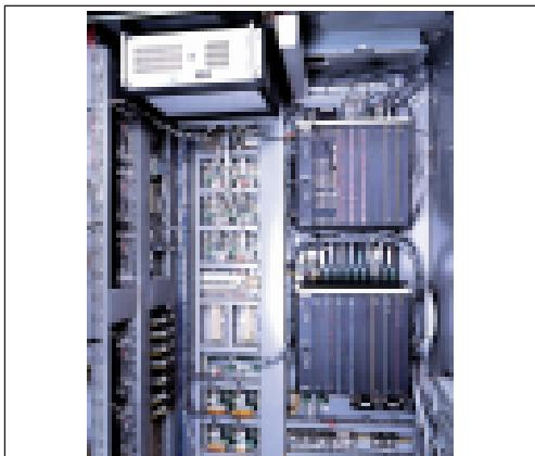
سیستم‌های کنترل توربین GE (جنرال الکتریک) با نام Speedtronic شناخته می‌شود که معروف‌ترین کنترل کننده منطقی قابل برنامه ریزی توربین در جهان می‌باشد. این سیستم جهت کنترل، راهبری، حفاظت و بهره برداری از انواع ادوات دوار شرکت جنرال الکتریک در توانهای مختلف، طراحی و مورد بهره برداری قرار گرفته و در صنایع مختلف اعم از نفت و نیروگاهی کاربرد دارد. سیستم کنترل parsii جایگزین یومی، داشت بیان و ساخت داخل سیستم کنترلی سری mark vi تایپ a (شرکت جنرال الکتریک) می‌باشد.
