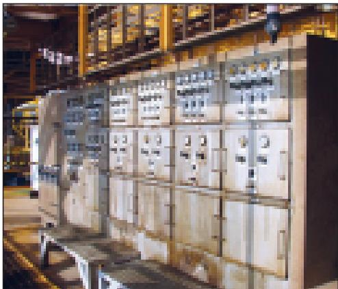
پتل Well Control یک واحد کنترل پنوماتیک / هیدرولیکی است که به گونه‌ای طراحی شده است که بتواند با اطمینان کار کند تا ز سه دریچه اصلی اینمی (SCSSV، SSV و SSSV) نصب شده بر روی چاه تولیدی (بهره ببرد و به این موارد محدود نمی‌شود، بلکه برای کار با سایر محرک‌ها و شیرآلات نیز استفاده می‌شود).
